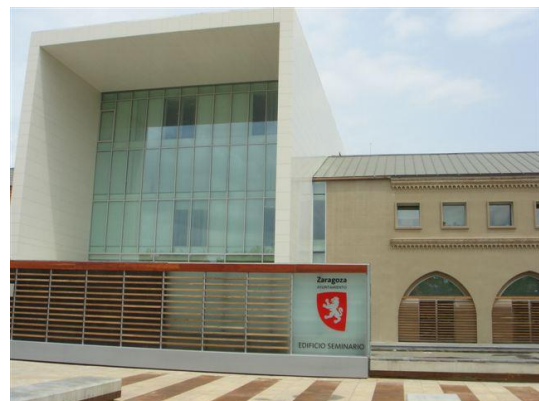
Fig 4. Rehabilitación bioclimática del edificio del antiguo Seminario Metropolitano
